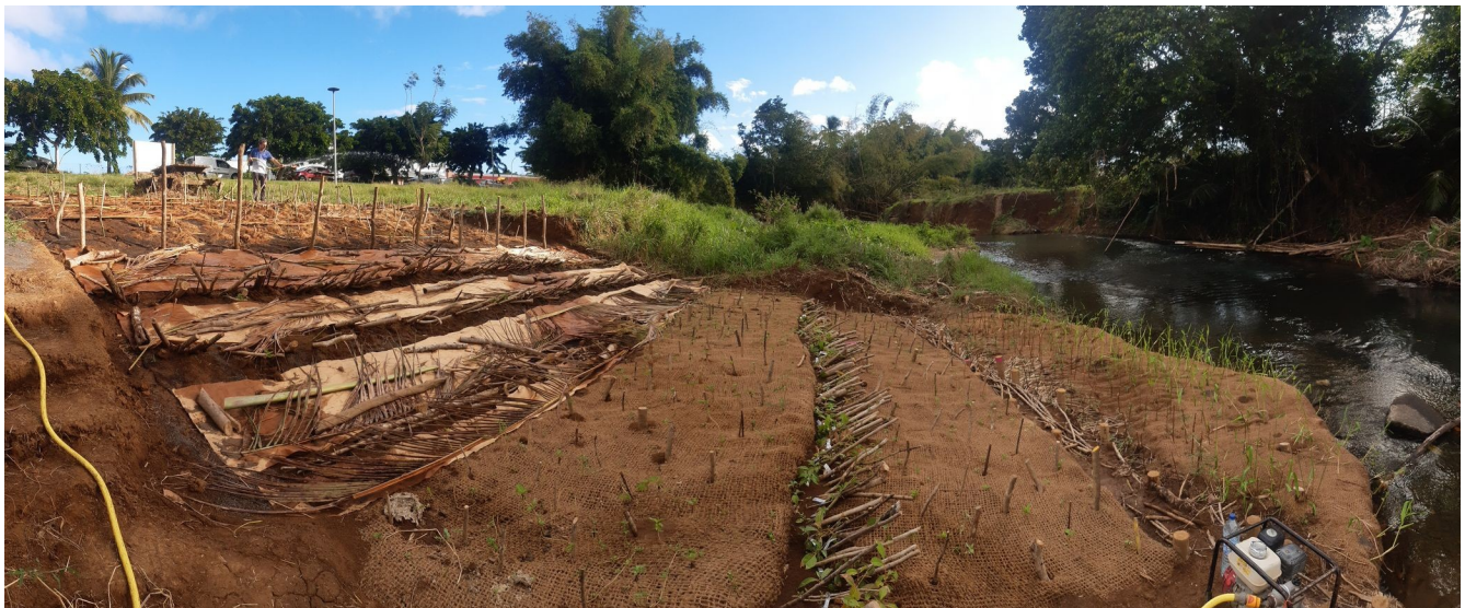
Figure 3: Aménagement génie-végétal, rivière La Lézarde
